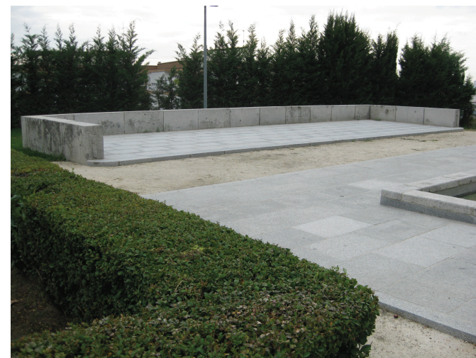
Figura 17: Pretil de coronación de la puerta con cerramiento temporal de sus entradas superiores.
