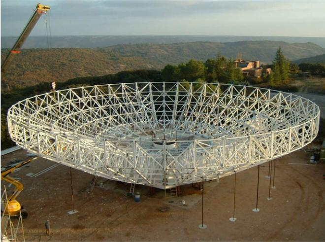
Figura 3: Soporte de la estructura del paraboloide del radiotelescopio de 40 m montado en Yebees a finales de 2003.
