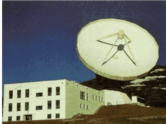
Vista frontal de las instalaciones
